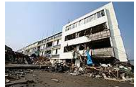
津波で押し流されたがれきで埋まり、使用できなくなった陸前高田市役所 ＝2011年3月13日撮影、岩手県陸前高田市 (時事)
